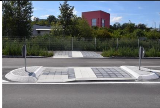
Barrierefreie Querungshilfe für Fußgänger in Frommern - ZAK
